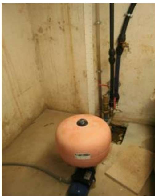
Figura 7 – Sistema de pressurização e controle de nível
