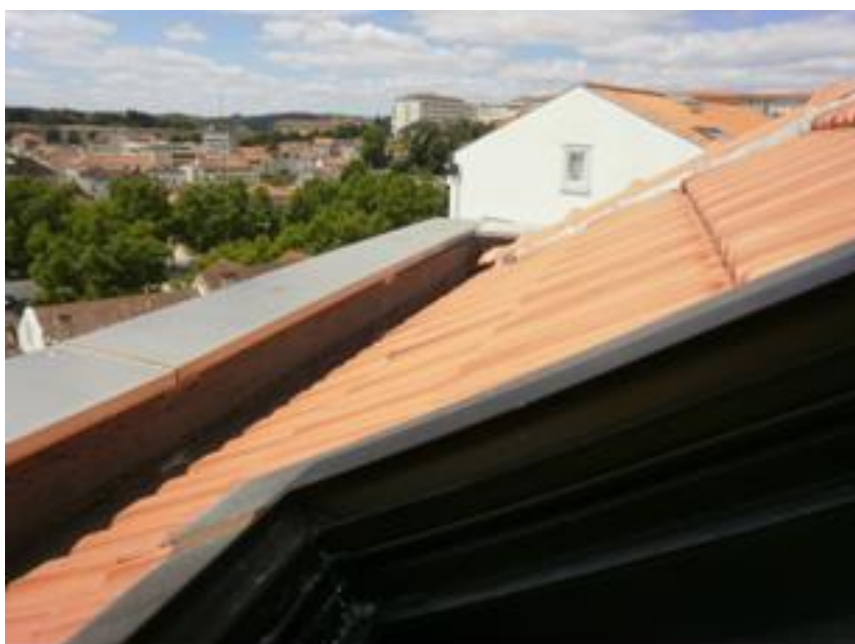
Figura 3 – Caleiras e drenagem nos telhados do edifício da OE
