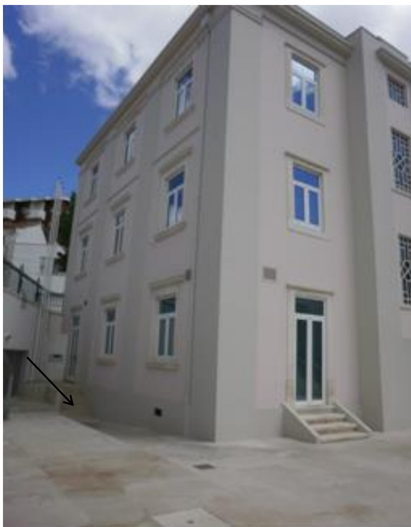
Figura 5 – O tanque de armazenamento de água sob o piso do terraço
