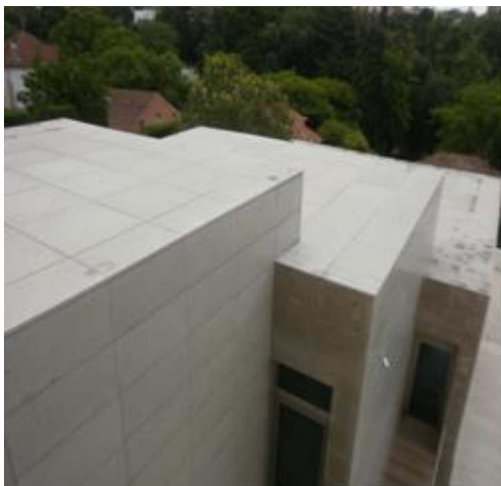
Figura 2 – Ordem dos Engenheiros – Nova construção (auditório)
