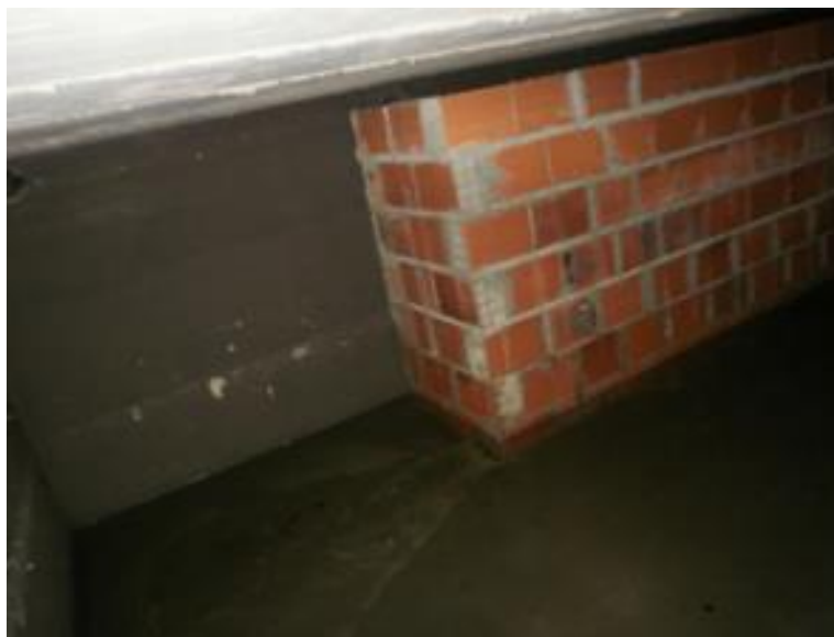
Figura 6 – O tanque de armazenamento de água sob o piso do terraço
