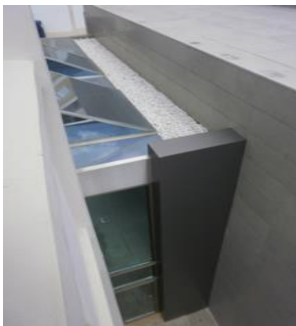
Figura 4 – Caleiras e drenagem nos telhados do edifício da OE
