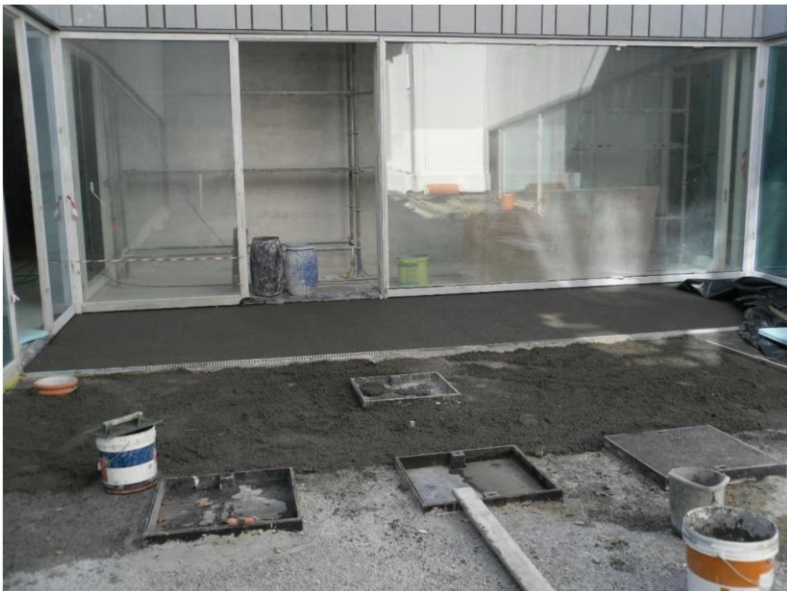
*Figura 4 – Construção do SAAP (cisterna enterrada)*
